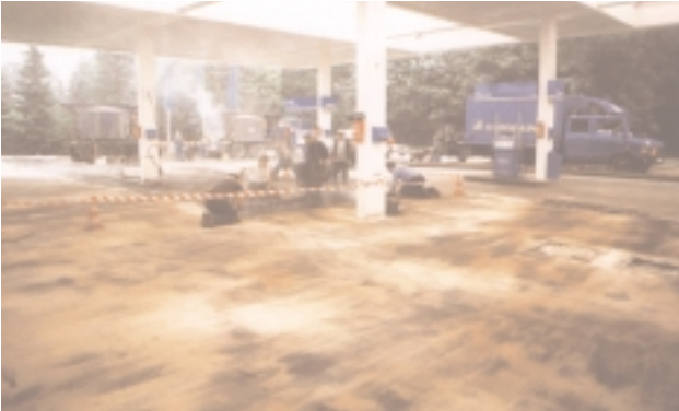
Bild 2: Gußasphaltverlegekolonne mit Transportrührwerkskesseln im Hintergrund
