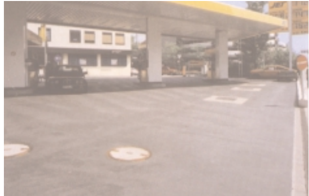
Bild 3: Fugenfreier, dichter Gußasphaltbelag einer öffentlichen Tankstelle
