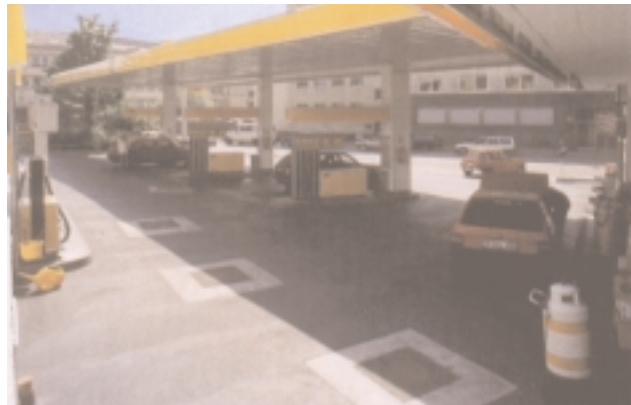
Bild 4: Öffentliche Tankstelle mit fugenfreier Gußasphaltdeckschicht
