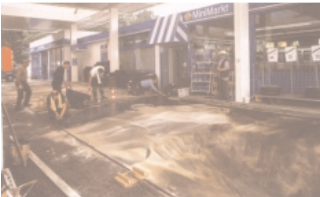
Bild 1: Gußasphalt im Handeinbau
