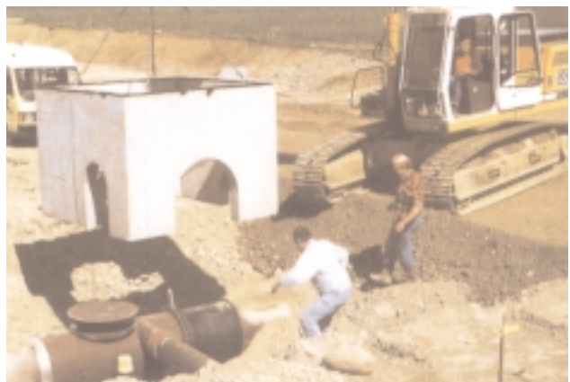
Versetzen der bodenlosen Schächte auf die Gußrohr-leitungen
