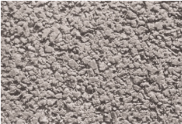
SMA 0/5 Plus Aschenbrennerstraße – 3 Monate nach dem Einbau
