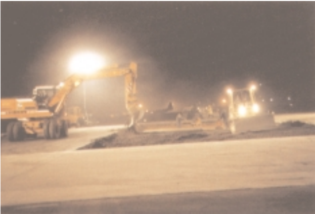
Einbau der Tragschicht
