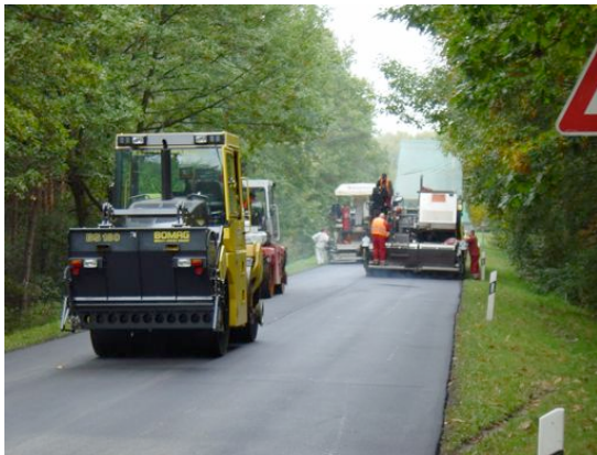
Einbau auf der L 31
